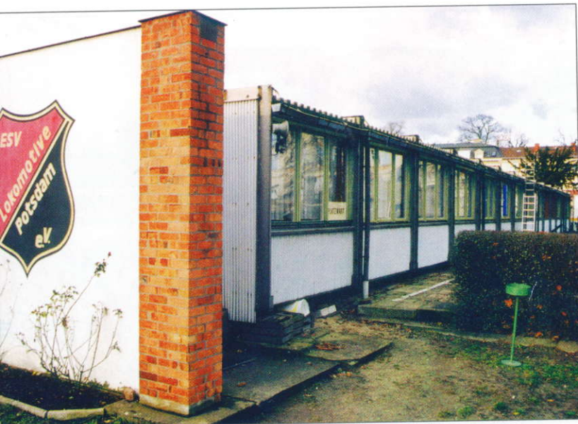
Raumzellentrakt mit Umkleideräumen
